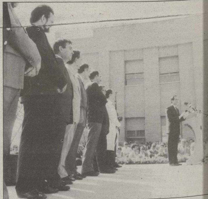
El nuevo Hospital, aún en la vía lenta.
