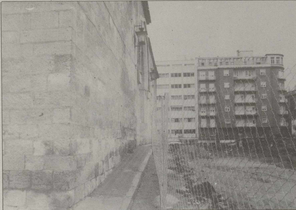
Según el constructor, un muro pantalla reforzará los cimientos de la Catedral.
