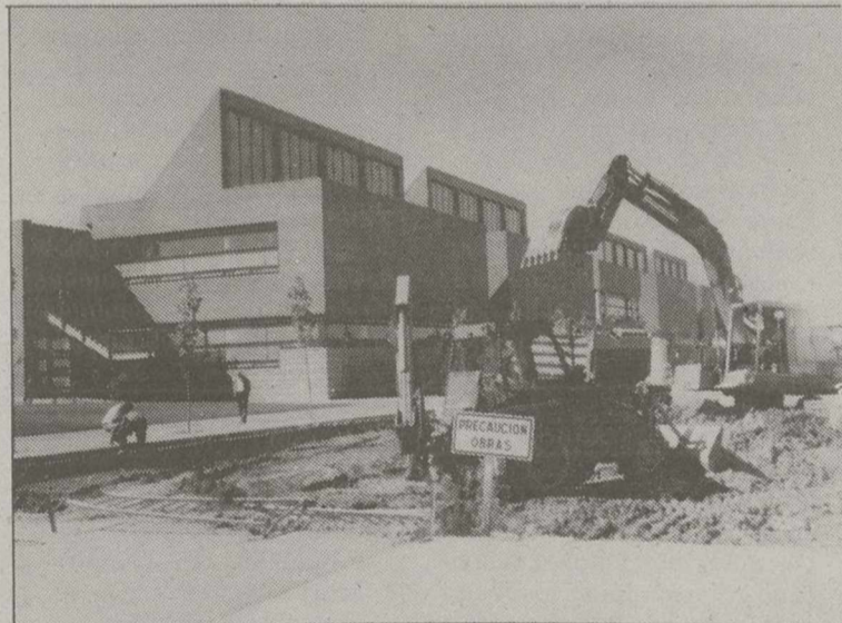
Se están realizando en el campus obras de acceso al centro de la Politécnica.
