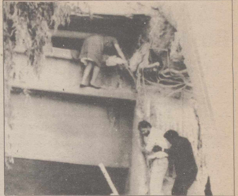
Los heridos se cuentan por cientos, lo mismo que las casas derrumbadas
