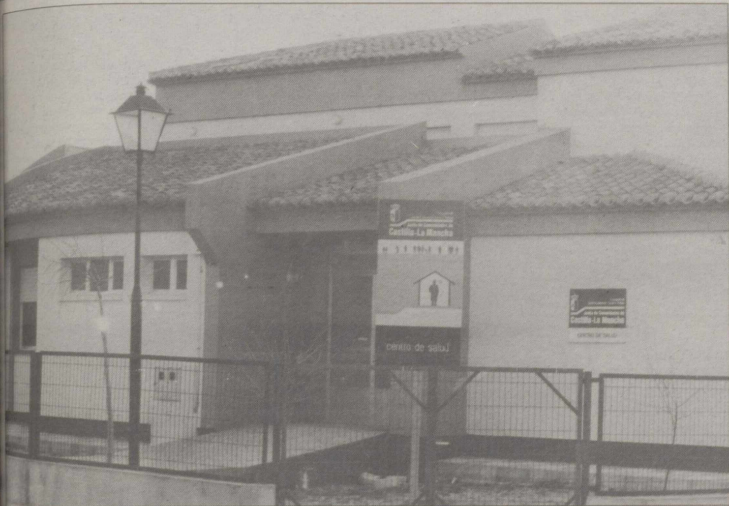
El edificio que albergará el nuevo centro de salud supuso una inversión estimada de 18 millones de pesetas.
