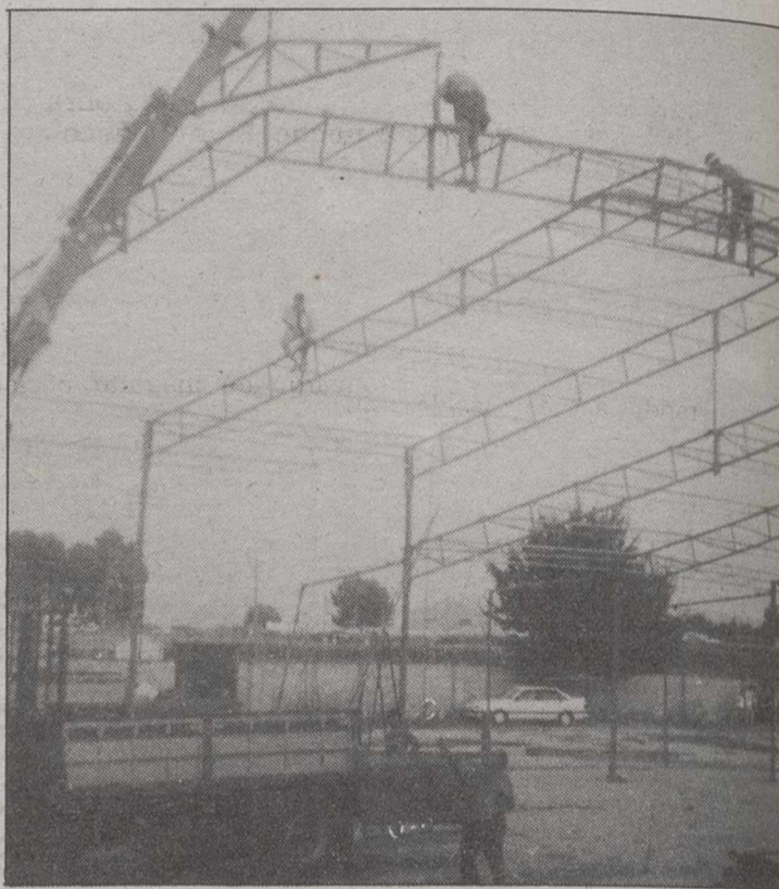
Obras de construcción de la Carpa Municipal de Almansa.
