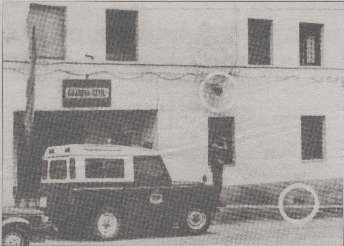
Impactos de las granadas que la pasada madrugada fueron disparadas contra la Casa Cuartel de la Guardia Civil en Orozco. No hubo que lamentar desgracias personales en el atentado
