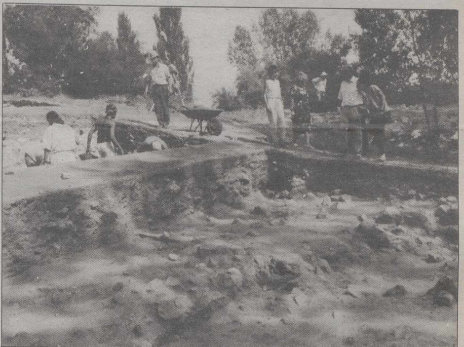
El alcalde comprobó cuál es el estado actual de las excavaciones.
