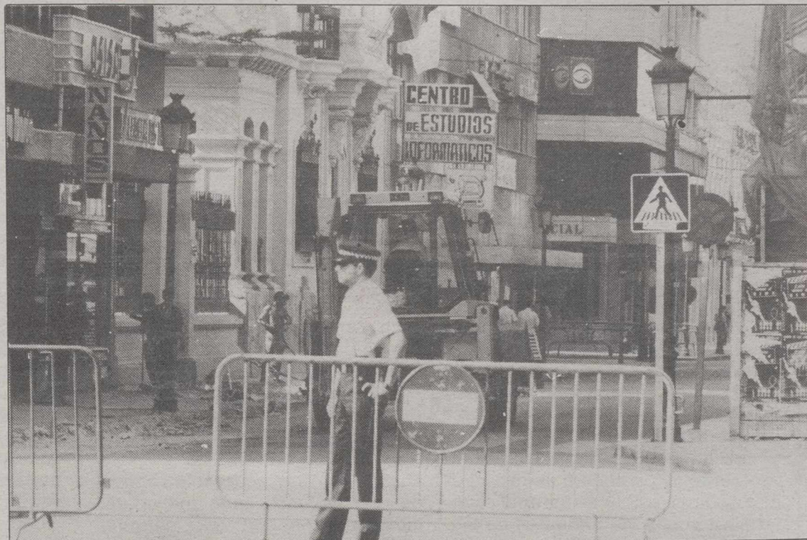
Las obras en la calle Ancha comenzaron ayer con el levantamiento de una de las aceras.
