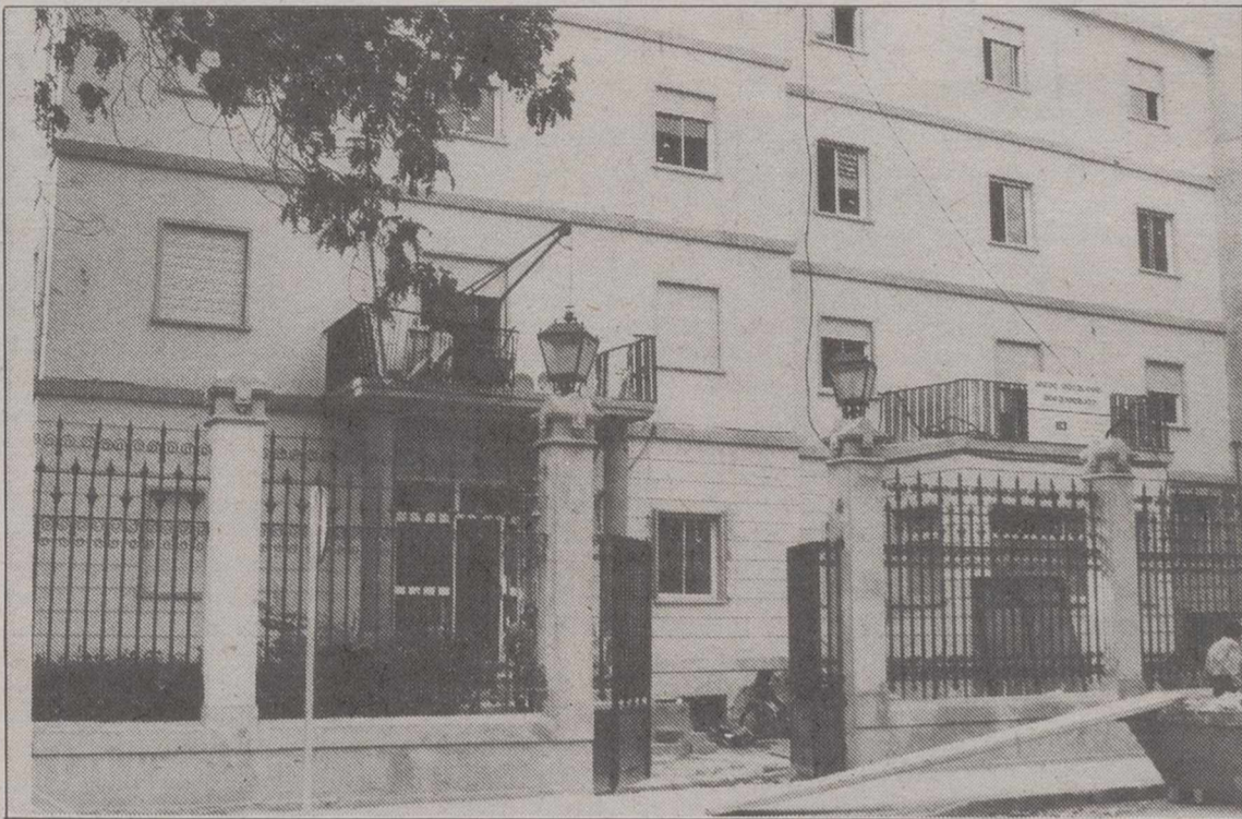
Fachada del Sanatorio.
