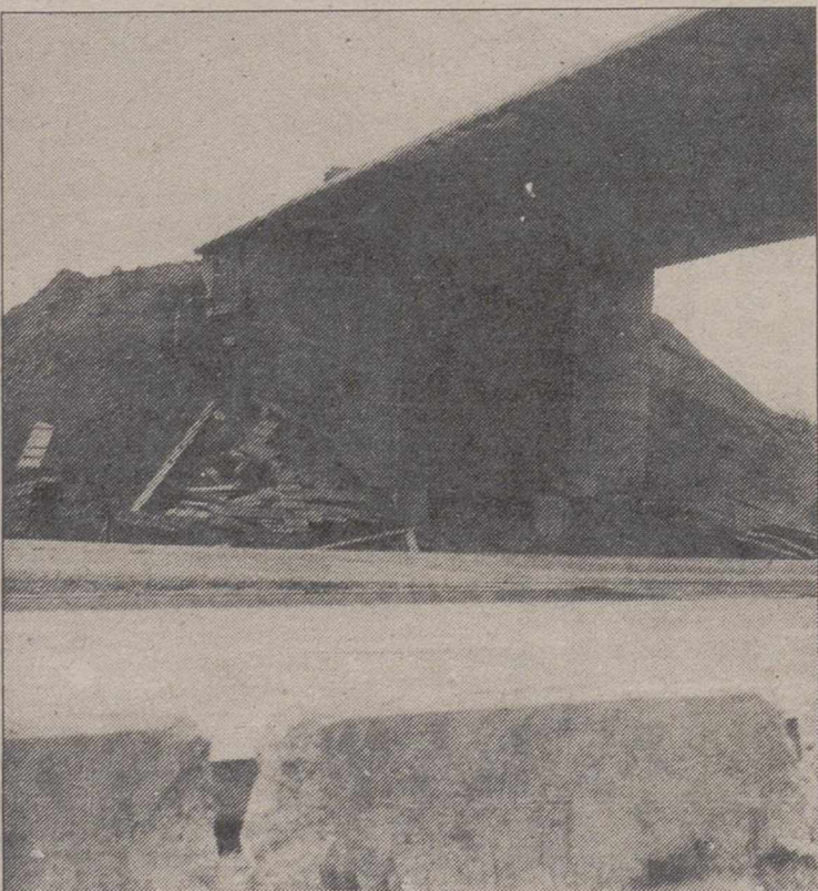
Una zona será construida de nuevo.
