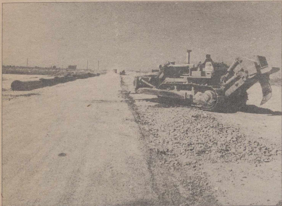
Con el comienzo de las obras hacía realidad una ilusión.
