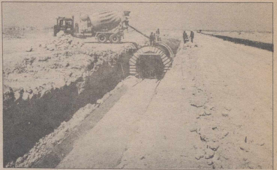
Así comenzaron las obras del Polígono.
