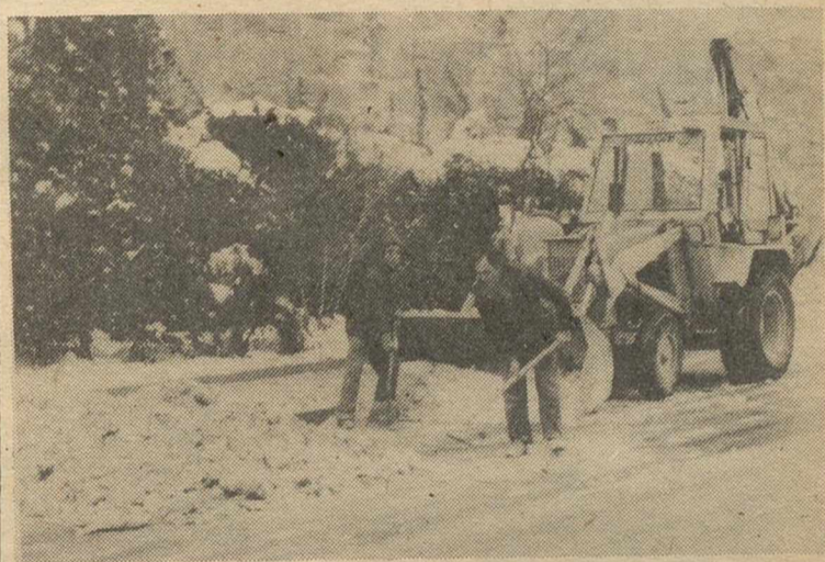
Las palas retroexcavadoras hicieron su trabajo de limpieza en las carreteras heladas.
