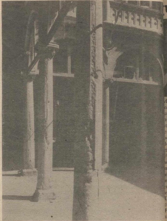
Las columnas del claustro, notoriamente afectadas por la acción meteorológica.
