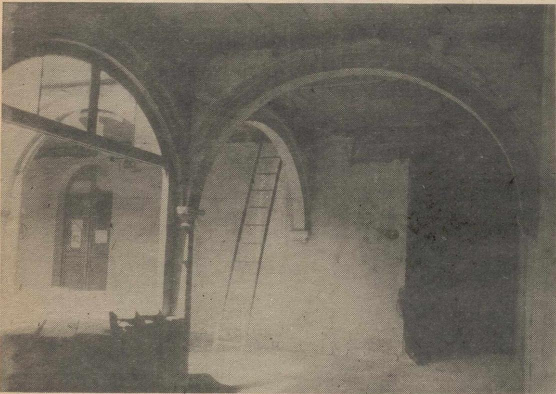
Los arcos de la galería superior, aunque con techo completamente nuevo y vigas metálicas, serán conservados.
