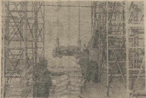
talar un andamiaje de seguridad con el fin de evitar una posible catástrofe en caso del desplome de la cubierta.
