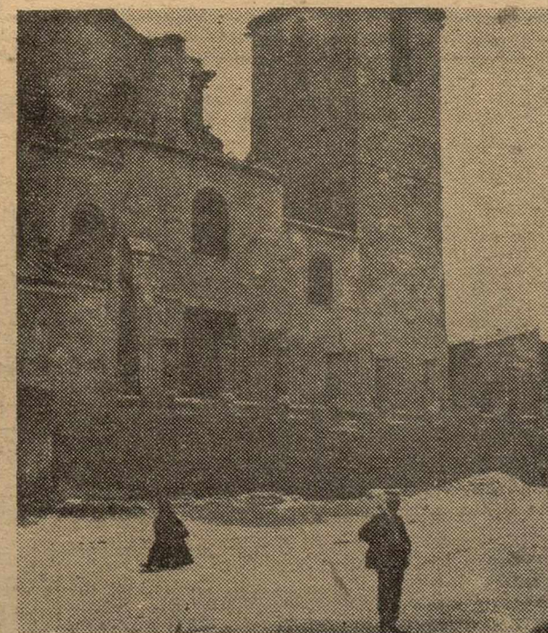
Dos «medias iglesias unidas de desigual arquitectura y de diferentes tamaños» componían el templo de San Juan: los restos del primitivo de igual advocación y la fábrica del actual. (Foto E. Navarro).
