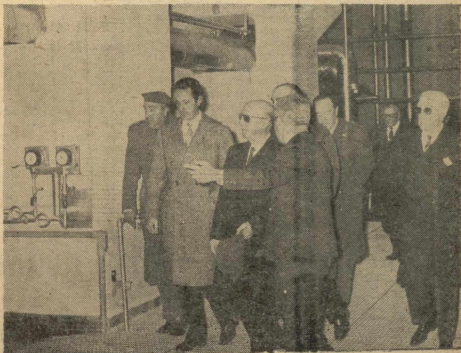
ZORITA DE LOS CANES (Guadalajara).—El Jefe del Estado, acompañado del vicepresidente del Gobierno, varios ministros y otras personalidades, ha inaugurado en esta localidad la Central Nuclear "José Cabrera", iniciándose con ella una nueva era de aplicación industrial y económica de la energía nuclear, y la cual producirá anualmente mil millones de kilovatios-hora, que se vertirán sobre el sistema de la Unión Eléctrica Madrileña, conectada a la red nacional. En la foto, el Caudillo durante su visita a las instalaciones de dicha Central. (Foto CIFRA-GRAFICA).
