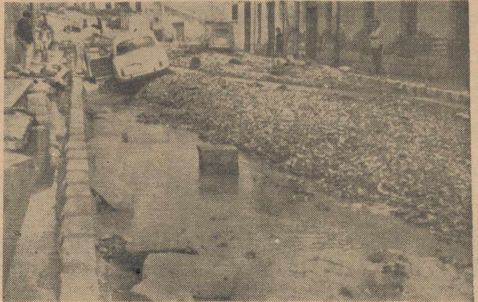
ALICANTE.—Aspecto de una calle alicantina tras la enorme tromba de agua que descargó aquí el sábado. Los daños producidos por el temporal se calculan en veinte millones de pesetas. La calle acababa de ser pavimentada.
