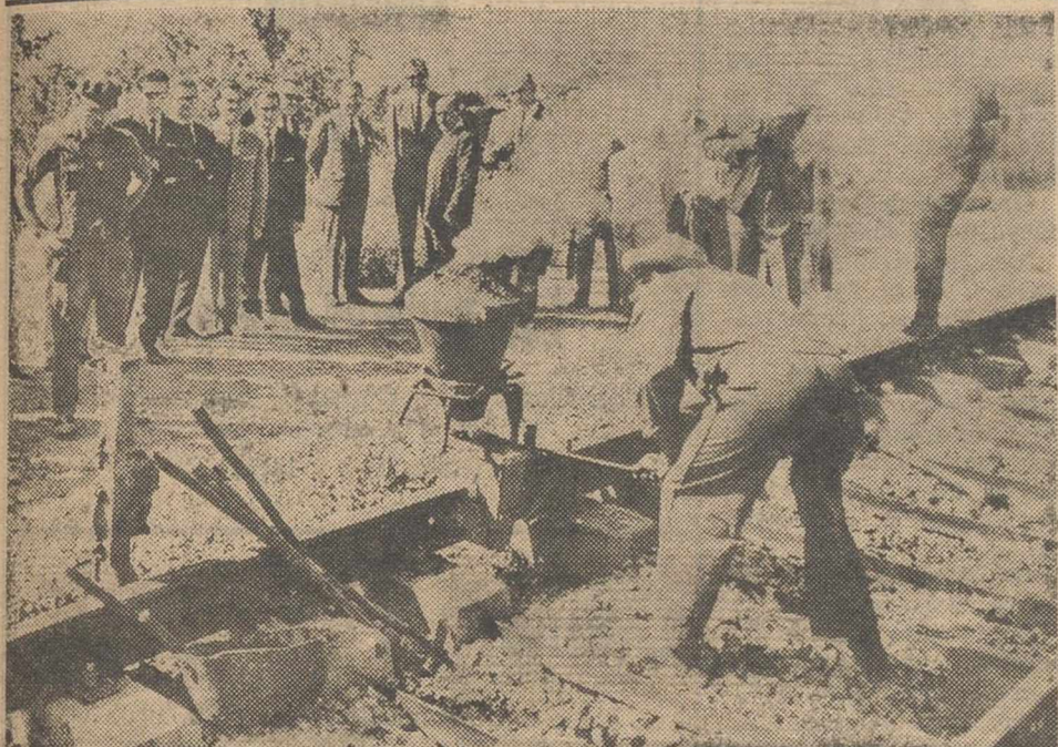
MIRAFLORES (Mañana).—El ministro de Obras Públicas, don Federico Silva Muñoz, acompañado de personalidades de su Departamento, observa una soldadura de carriles durante su visita a las obras del ferrocarril Madrid-Burgos (Foto Europa Press)
