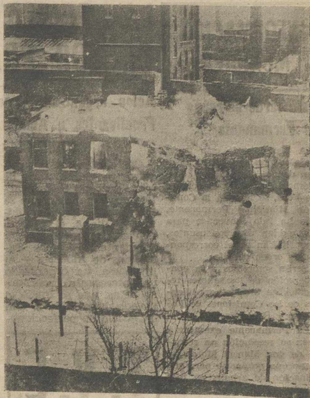
Una de las últimas casas que aún se mantenían en pie tras el «muro de la vergüenza», en la Liesenstrasse, en Berlín oriental, se desploma bajo los efectos de la dinamita. Las autoridades comunistas pretenden crear un glacis, tanto para los guardias del muro, como para evitar que los fugitivos se oculten en las casas situadas junto a aquél. (FOTO FIEL)
