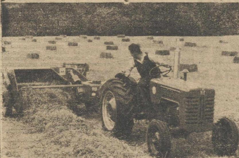
Una nueva embaladora-recogedora británica, la B 46, que viene a sustituir a la B-45, realiza una demostración en pruebas de campo llevadas a cabo en Inglaterra durante la recolección de heno. Con una capacidad clasificada en nueve pacas de 76'2 cm. por minuto—aunque se han conseguido regímenes de trabajo de hasta 10 toneladas de heno por hora—, esta máquina es «la embaladora de densidad media de precio casi más bajo que se halla en el mercado».
