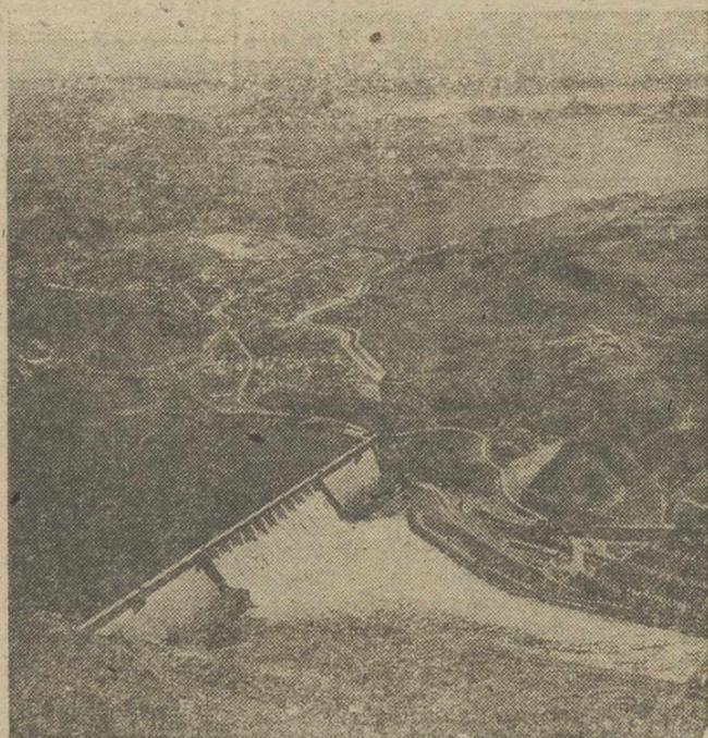
La presa Grand Coulee, es una mole de más de 8 571.000 metros cúbicos de hormigón y tiene una altura de 168 metros, siendo su longitud de 1.280 metros. Esta presa alimenta una batería de 18 generadores capaces de mantener una producción de 2.000.000 de kilovatios por lo menos.
