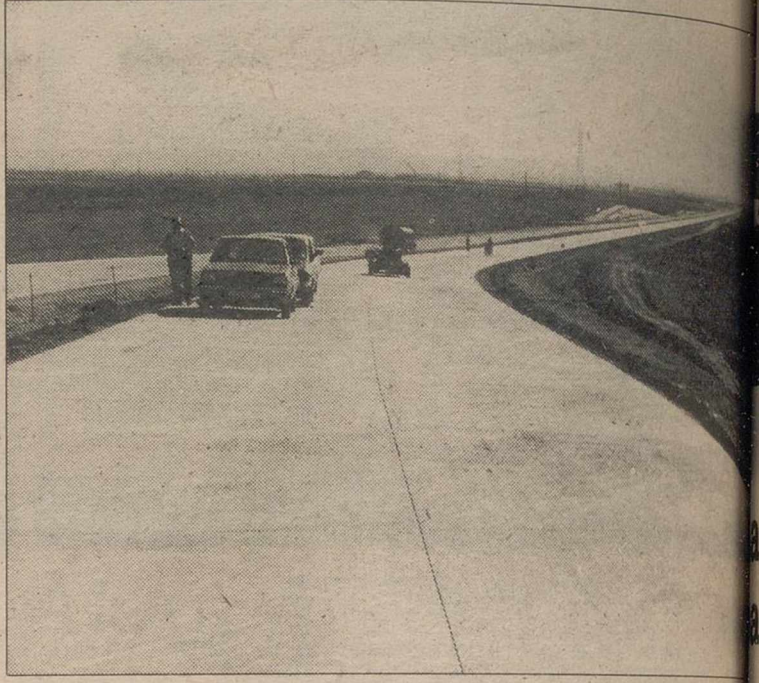
El trazado de la futura autovía avanza a marchas forzadas.
