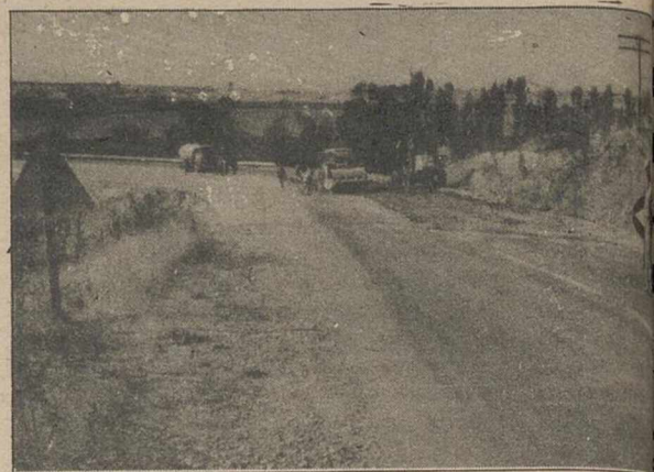
La nacional Córdoba-Valencia, a su paso por Villapalacios, encuentra ya perfectamente asfaltada.
