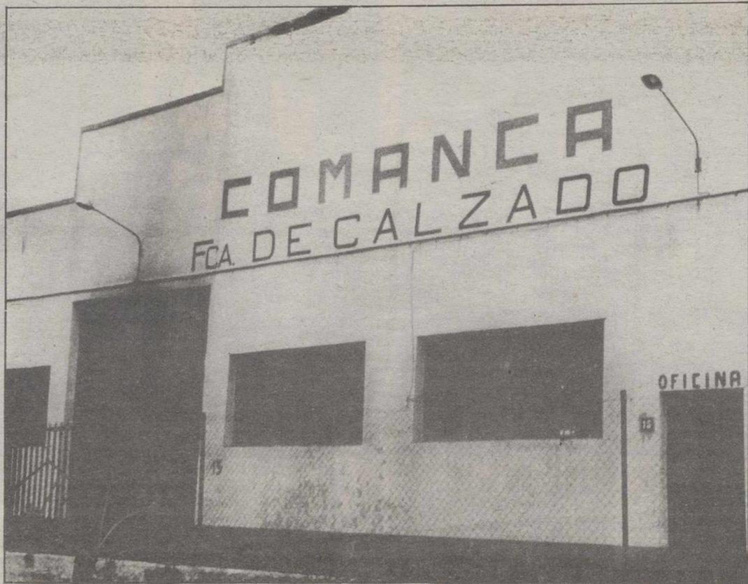
Así quedó la nave de la cooperativa tras el incendio.
