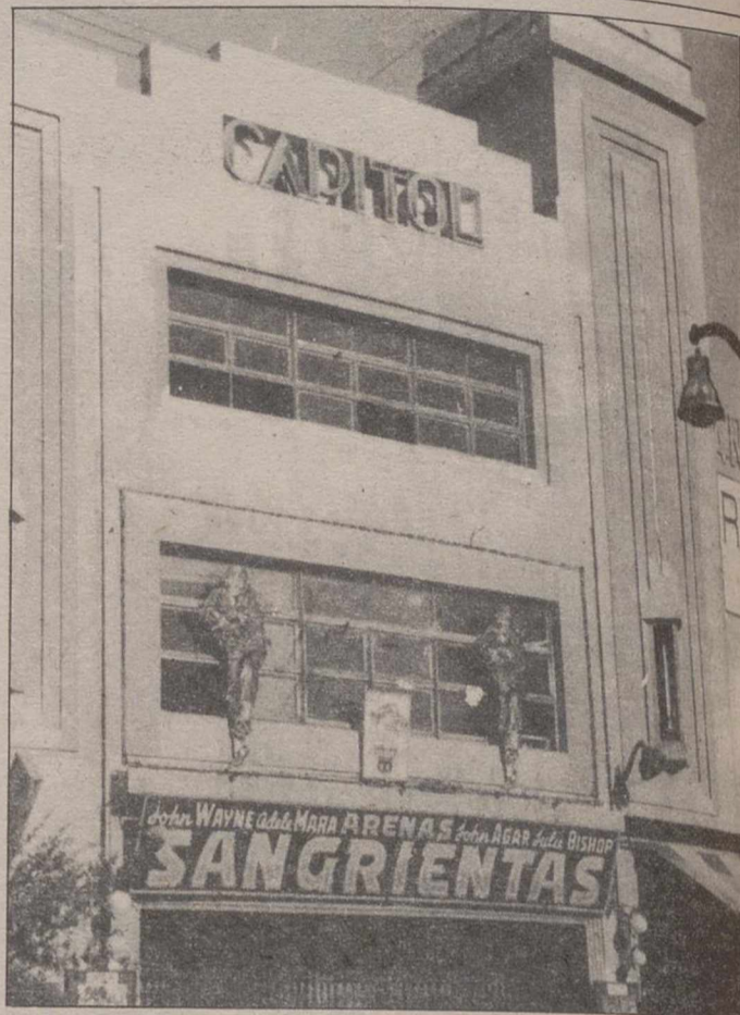
Vista del edificio uno de los más modernos del momento.
