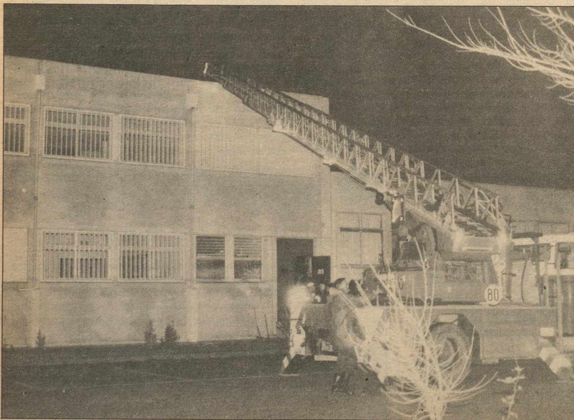
El Parque ha sido dotado del más moderno material para la extinción de incendios.
