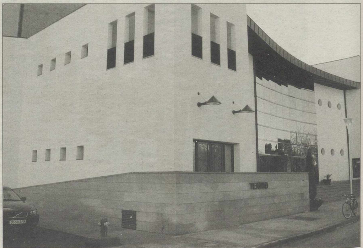
Todas las obras darán comienzo a partir de las nueve de la noche, y tendrán un precio de 5 euros. / AM
