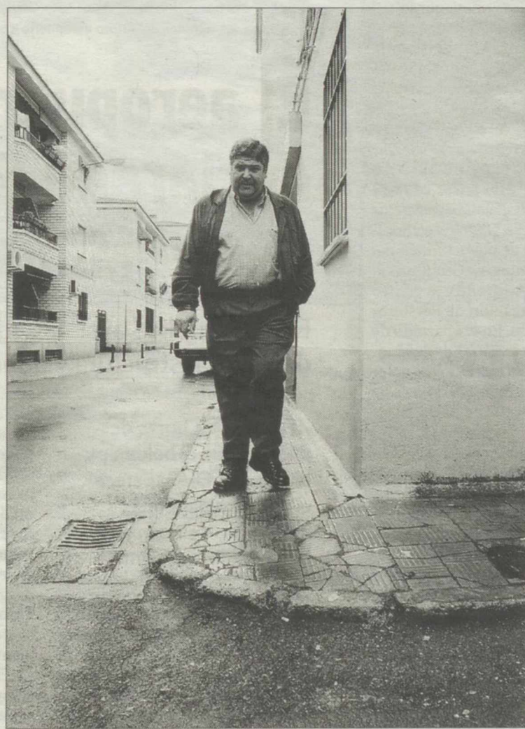
Aurelio Borja camina sobre una de las zonas con el pavimento destrozado.
