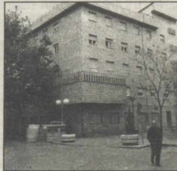
Vista general del edificio Rueda Villaverde
