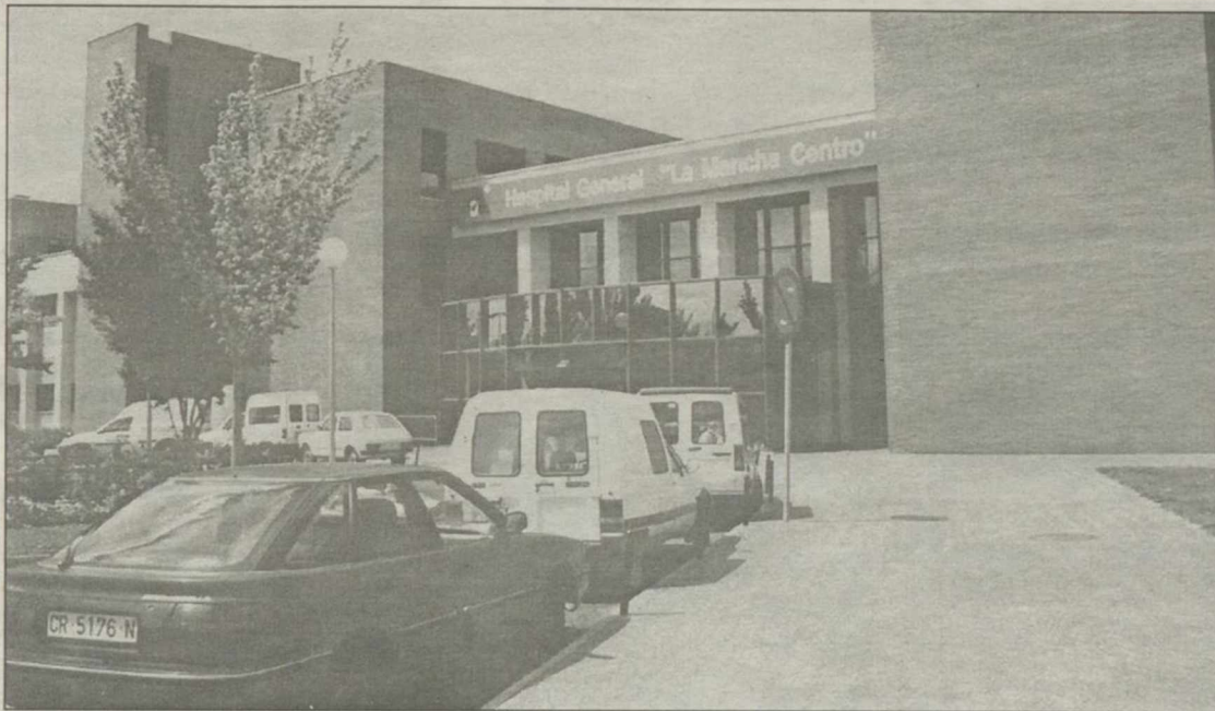
Fachada del hospital de Alcázar de San Juan
