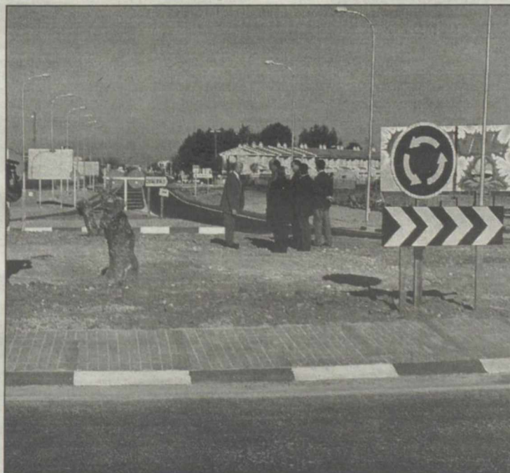
Las obras cuentan con un presupuesto de 40 millones
