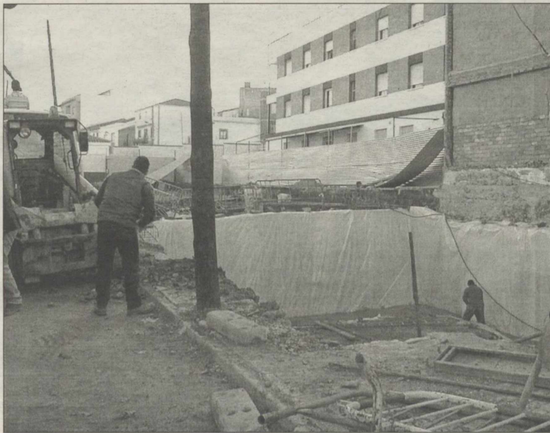
Imagen del estado actual de las obras del Centro de Día y Hogar para Pensionistas
