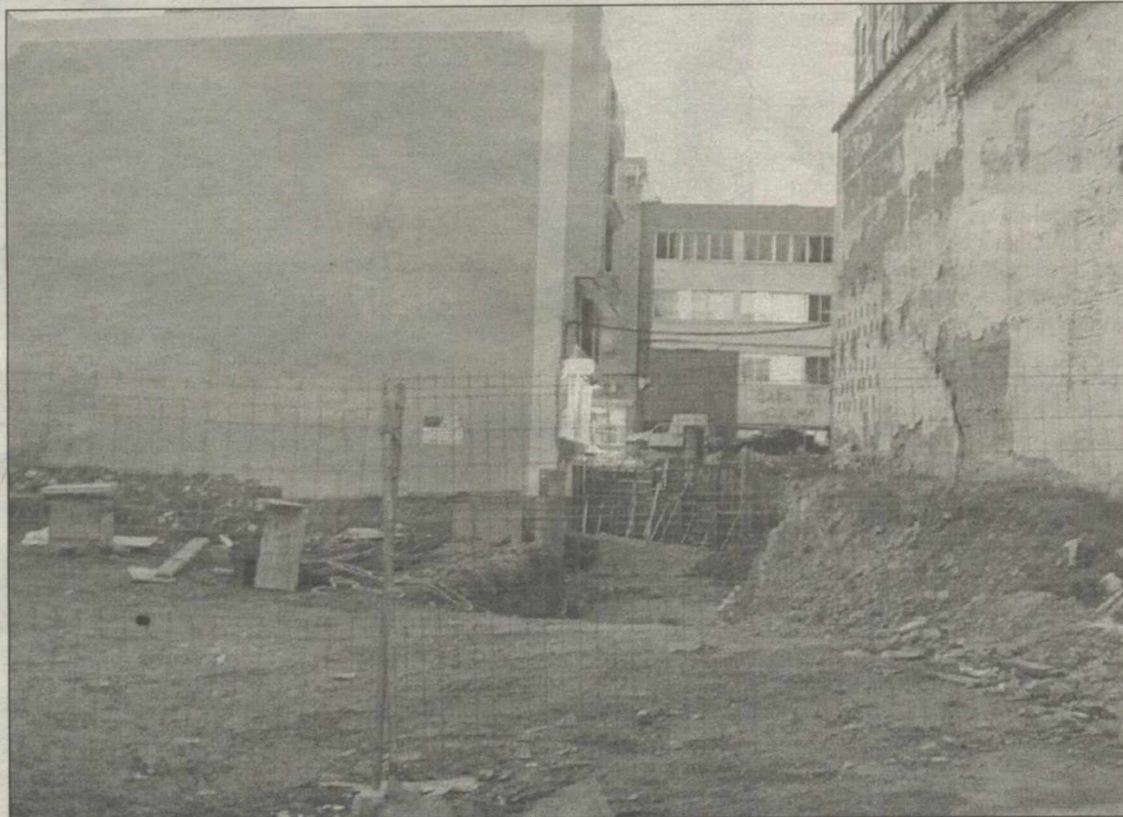
Las obras han comenzado por la calle Calzada.
