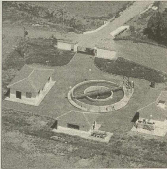
Vista aérea de la planta de Alcubillas
