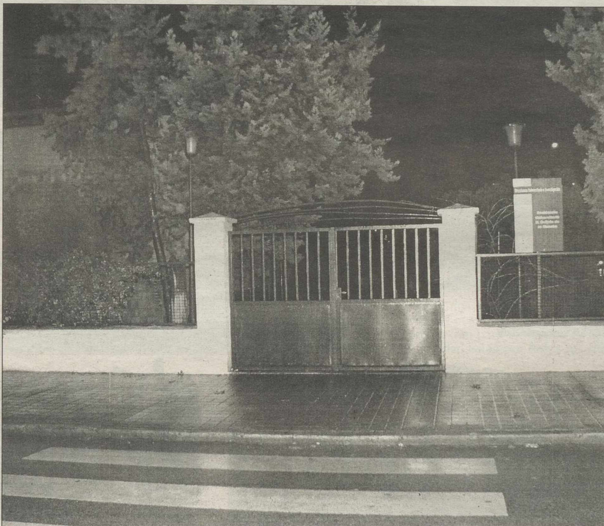
En la imagen, la fachada exterior de "El Doncel" que está en obras.
