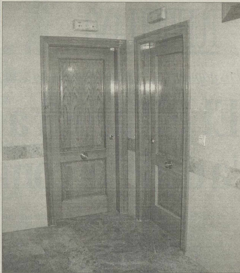
Las puertas de la vivienda deben ser seguras.
