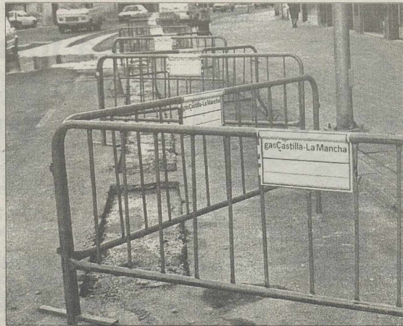
Señalización de obras para instalar el gas natural.
