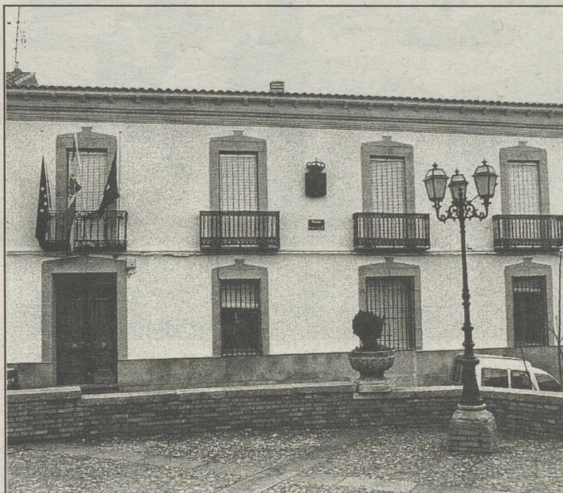
El Ayuntamiento colabora en la financiación de la depuradora.
