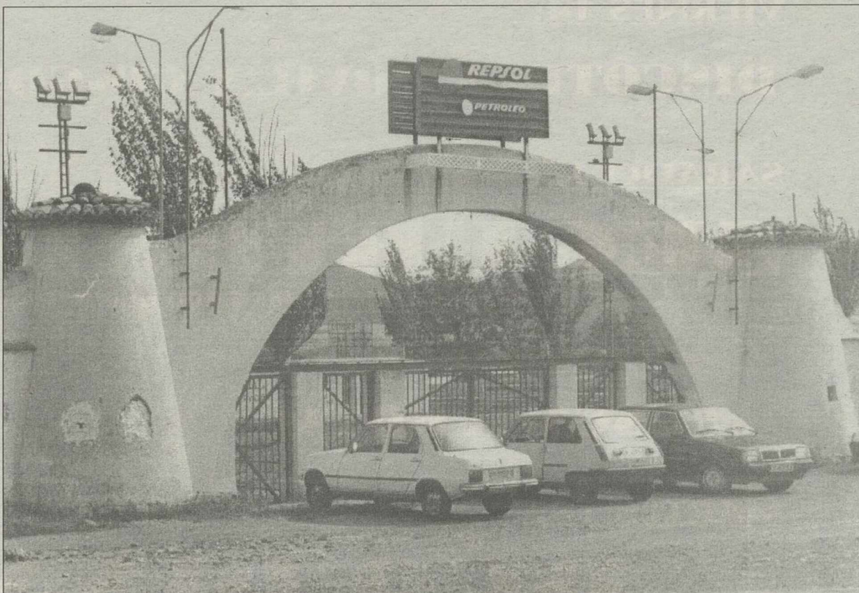
El complejo deportivo tiene unas instalaciones muy deterioradas.
