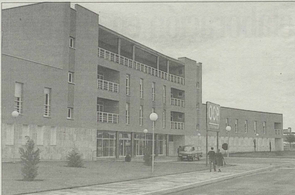
Las obras de acondicionamiento del servicio de Rehabilitación se iniciarán en los próximos días.
