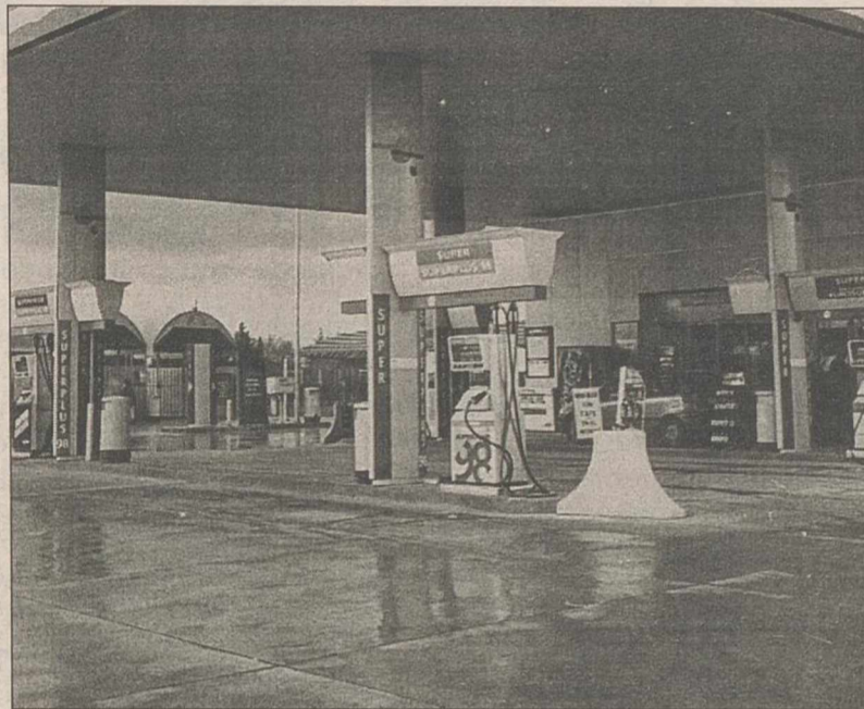
Aspecto de una estación de servicio.
