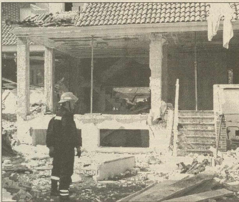
La explosión destruyó el chalé.
