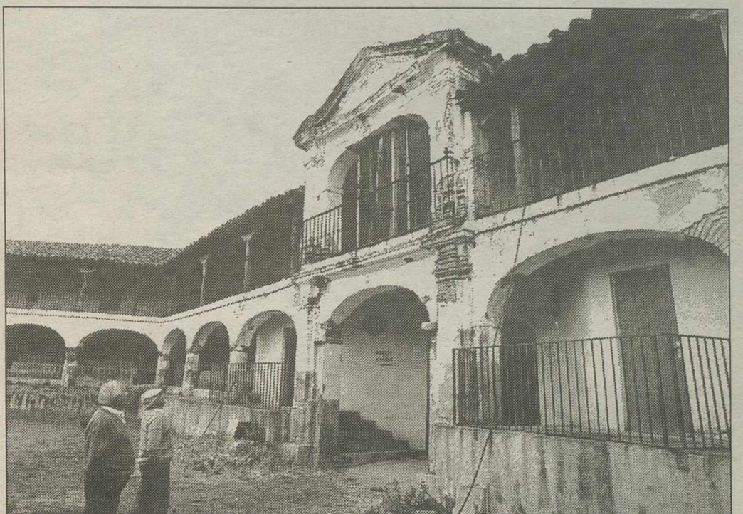
Aspecto que presenta la Plaza de Toros hexagonal de Almadén. RUEDA
