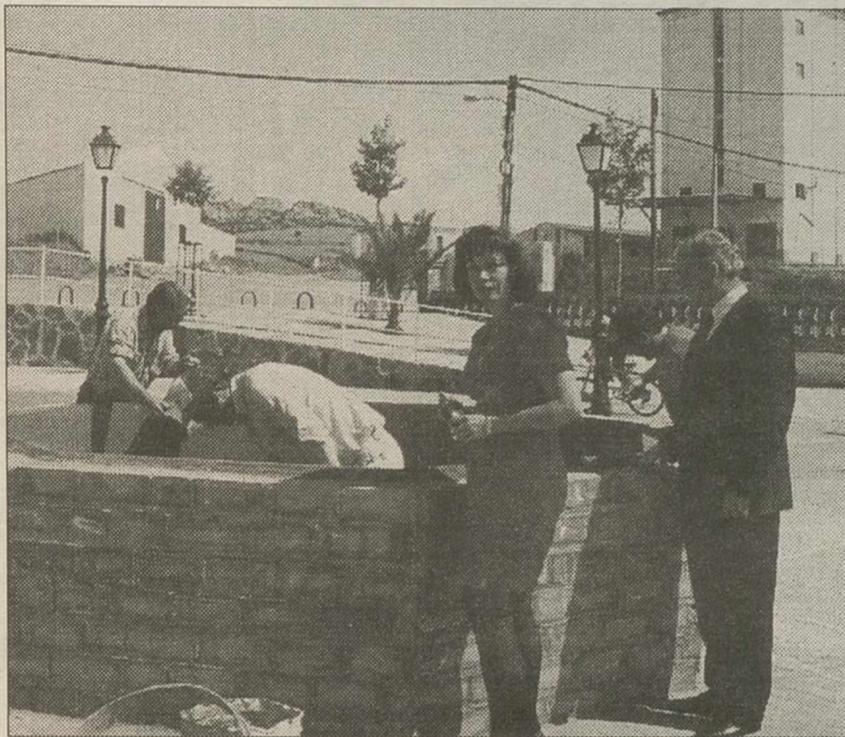
La alcaldesa visitó recientemente las obras.
