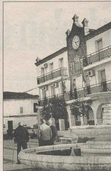
Renovación de redes en Chillón.
