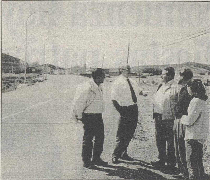
Los delegados y el alcalde comprueban el estado de las obras.
