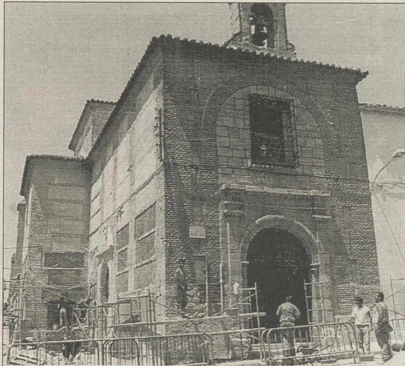
Aspecto que presentan las obras en la fachada.
