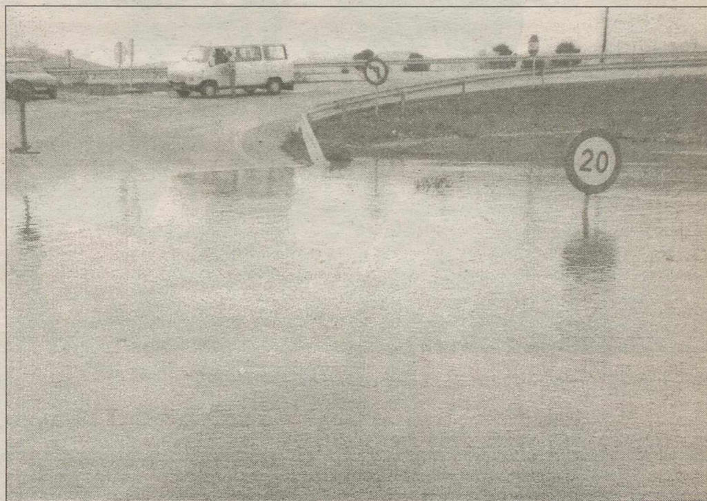
Un tramo que une la carretera de Malagón con Ciudad Real estaba anegado.
