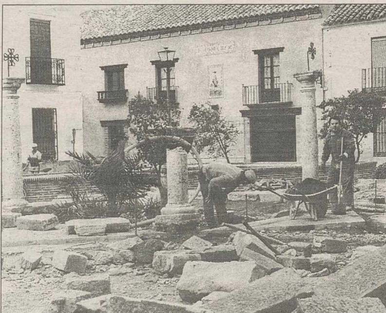
Las obras comenzaron el mes pasado.
