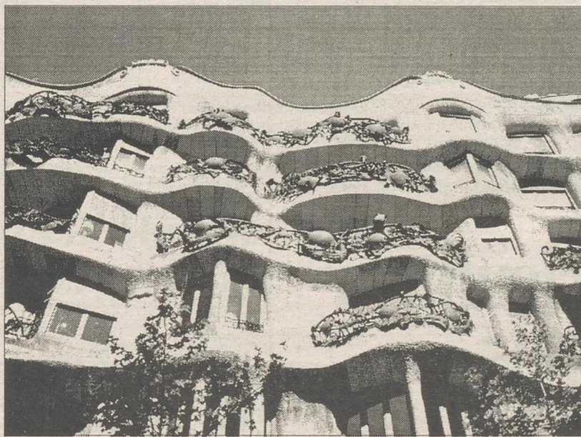
Casa Milà, "La Pedrera", punta de lanza de los edificios del Ensanche.
