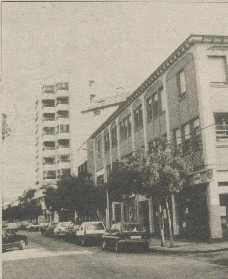
Alcázar depura diariamente 12.000 m3 de agua
