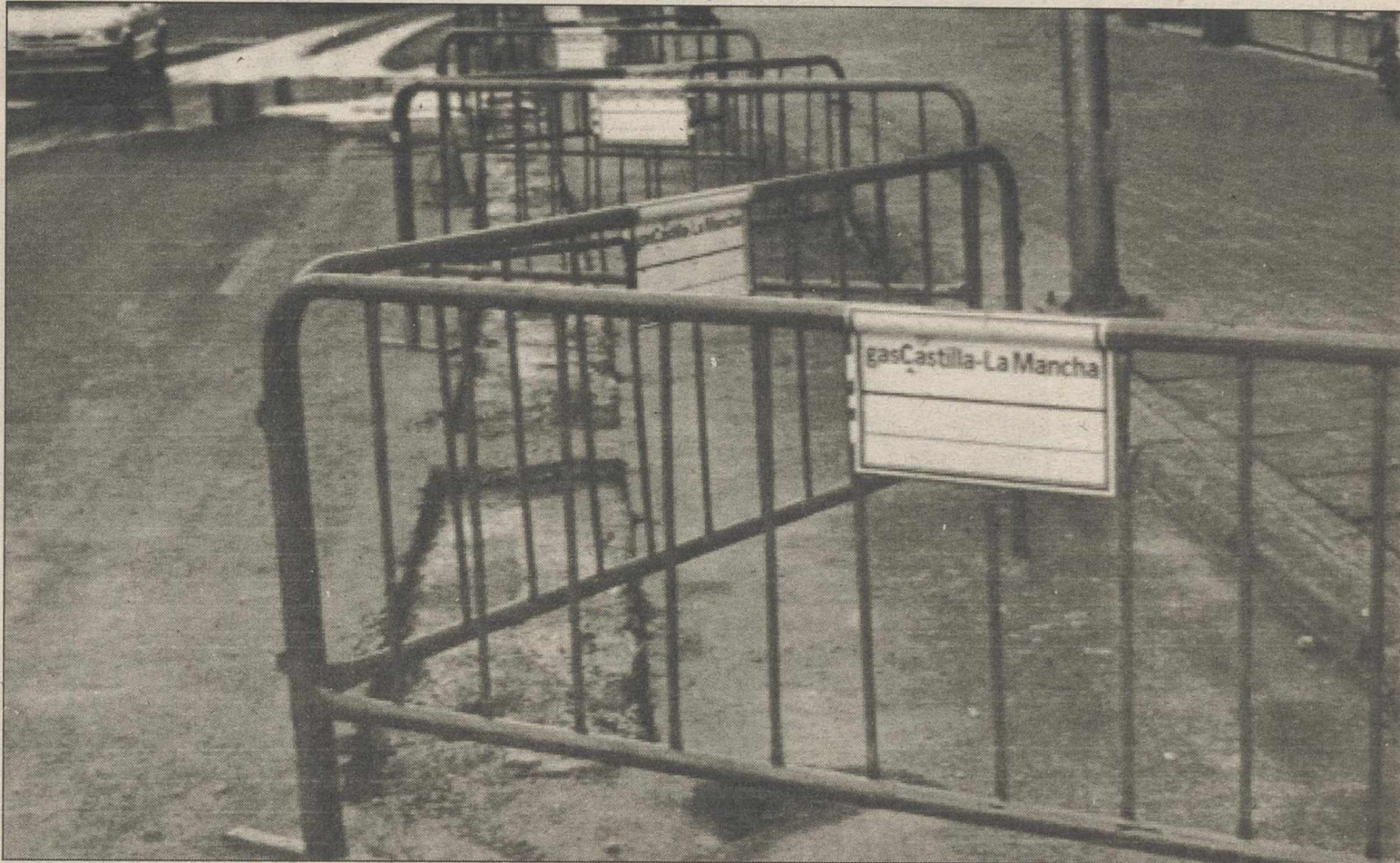
La empresa Gas Castilla-La Mancha está encontrando muchas dificultades para instalar la nueva energía
