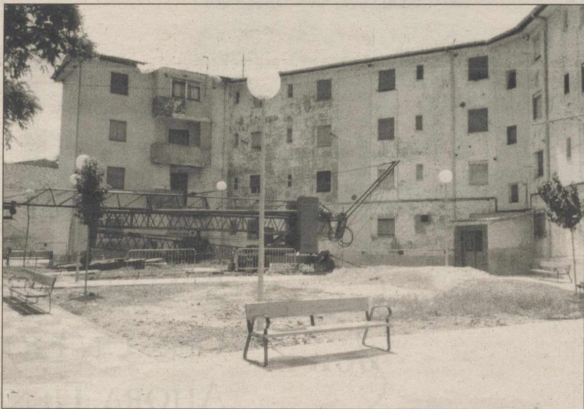
Las nuevas viviendas estarán junto a las antiguas de esta barriada
